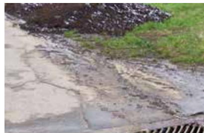
Abb. 3: Trester-Haufen mit Sickerwasserbildung und betoniertem Wirtschaftsweg. Foto: M. Erhardt
